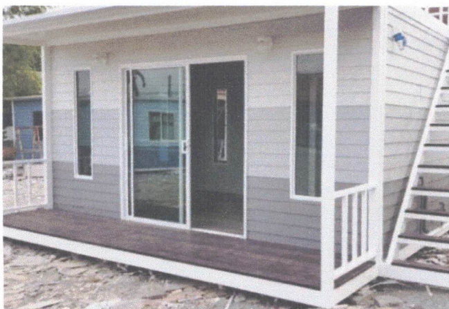
บ้านประกอบเสร็จ
